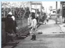
側溝清掃の様子
