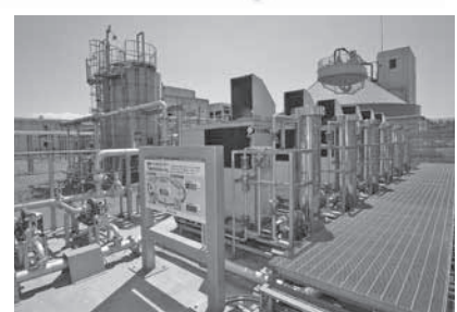
▶ 下水処理で発生する消化ガスを利用した発電施設
