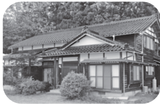
外装は改修の必要がなかった
