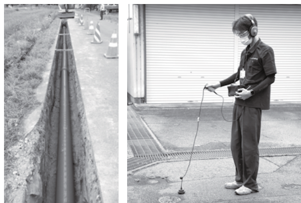
新たな水道管への更新工事（写真左）と漏水調査（右）。水道は常に稼働しているため、水道管からの水漏れがないか日頃から点検を行い、漏水の際にも迅速に対応しています。
