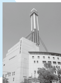
▲タワーホール船堀
