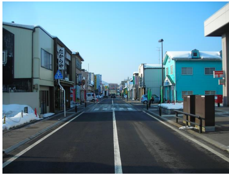
山王商店街みち空間再生事業 (歩道拡幅・無散水融雪・無電柱化)
