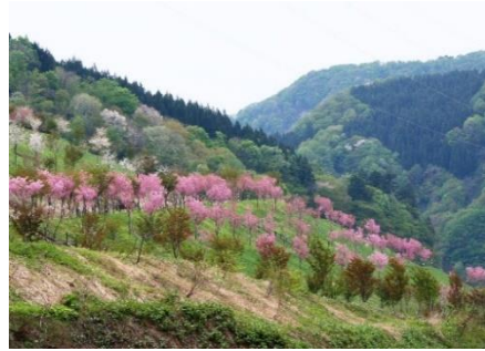
国道 112 号から見た月山ダムの桜
