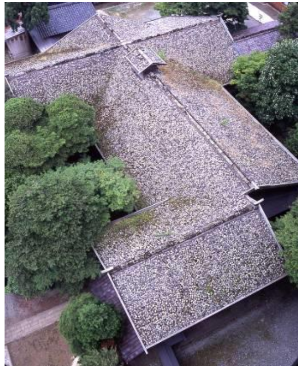
重要文化財 旧風間家住宅の石置屋根
