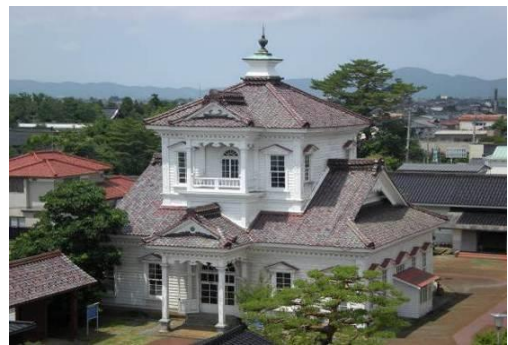
重要文化財 旧鶴岡警察署庁舎
