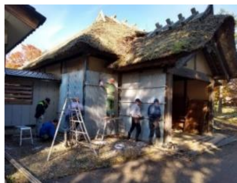
本陣の雪囲い作業
