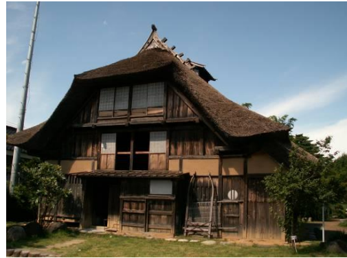
重要文化財 旧洪谷家住宅
