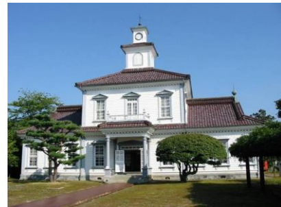
旧西田川郡役所
