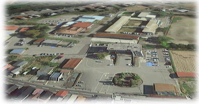
※現在の朝日庁舎と周辺施設
