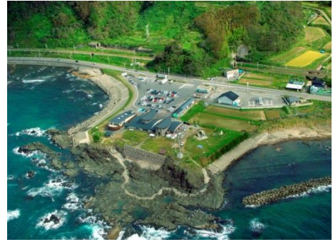
道の駅「しやりん」の全景
