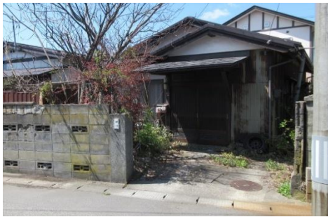
家中新町の解体前写真
