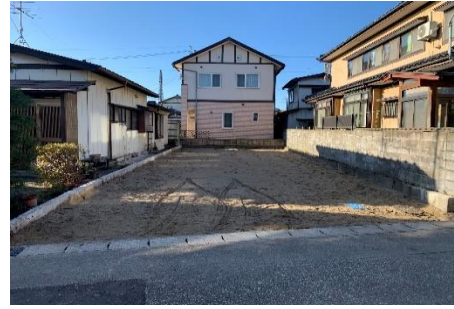
家中新町の解体後写真
