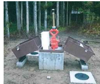
正善院黄金堂(放水銃 施行後)
