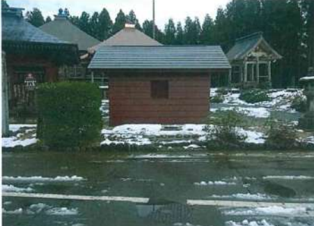
道路(南)側ポンプ室状況 地下式貯水槽
