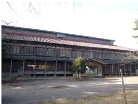
2番蚕室の前景(施工前)
