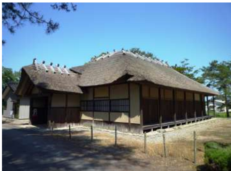
本陣の前景(施工前)
