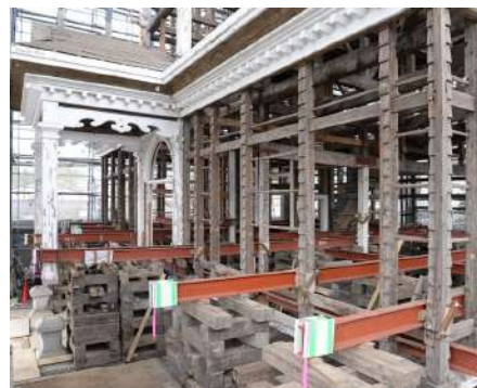
旧鶴岡警察署庁舎(揚屋作業状況)
