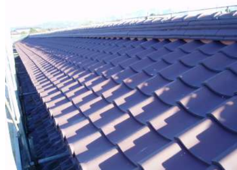
2番蚕室3階屋根修理避雷設備設置状況
