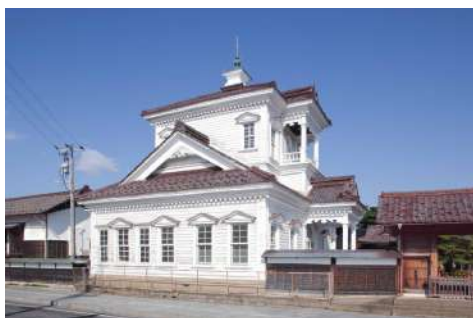
旧鶴岡警察署庁舎外景(施工前)
