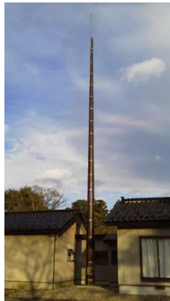
本陣裏パンザマストの全景(施工後)
