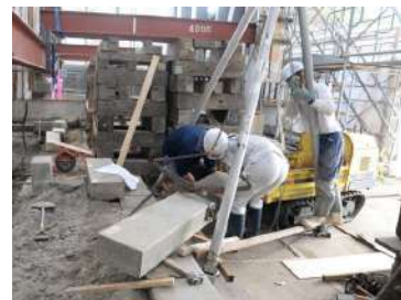
旧鶴岡警察署庁舎(礎石交換作業状況)
