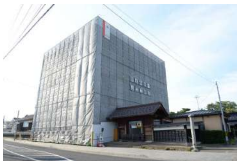
旧鶴岡警察署庁舎外景(施工中)
