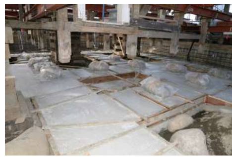
旧鶴岡警察署庁舎内部(施工中)
