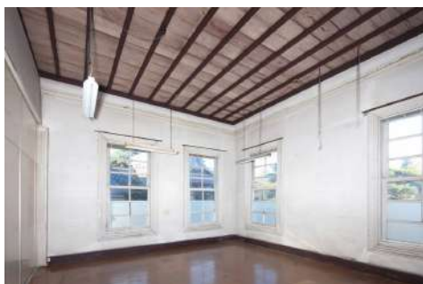
旧鶴岡警察署庁舎内部(施工前)
