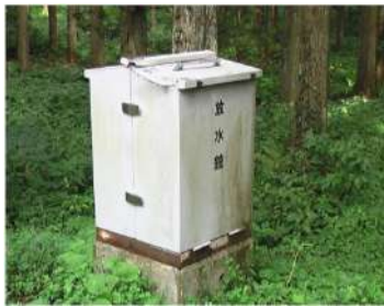
正善院黄金堂(放水銃 施工前)
