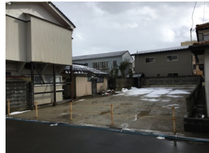
昭和町2棟の解体後写真
