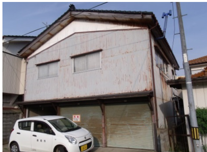
昭和町2棟の解体前写真
