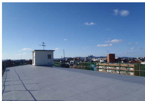
屋根改修工事
