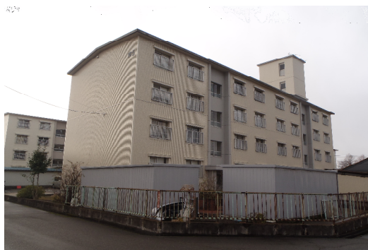
外壁改修工事
