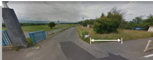
▲進入路拡幅(三川橋側)
