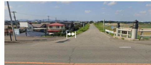
▲進入路拡幅(羽黒橋側)
