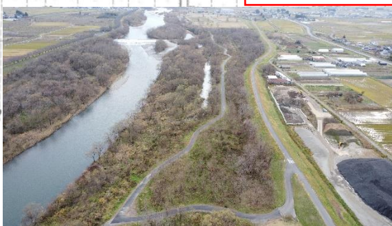
管理用通路 完成写真
