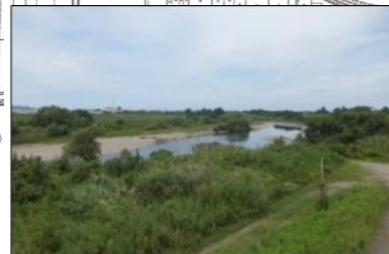
▲整備後（川面の見える景観）
