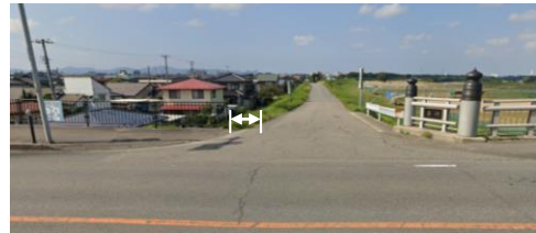
▲ 進入路拡幅(羽黒橋側)
