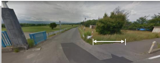
▲ 進入路拡幅(三川橋側)
