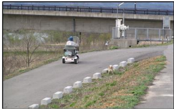
▲電動カートでの利用
