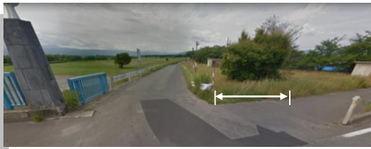
▲進入路拡幅(三川橋側)
