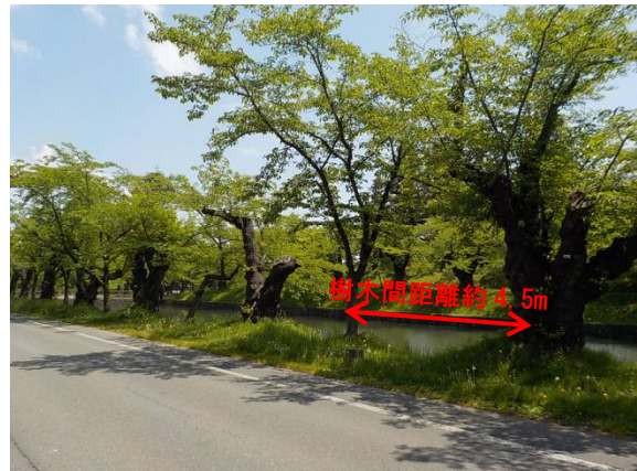
写真4 堀端植栽状況（致道博物館側）
