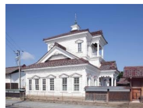
旧鶴岡警察署庁舎外景 (修理前 H25)
