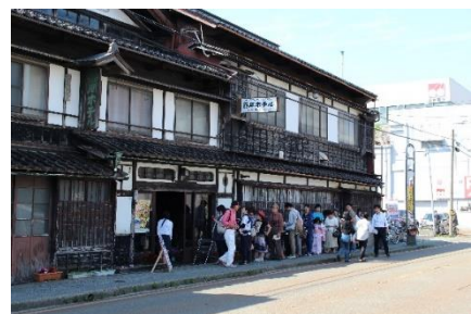
旧鶴岡ホテル 明治期に建築されH26廃業 意匠に優れた趣のある木造建築物 中庭に樹齢百年超の藤棚を有す。
