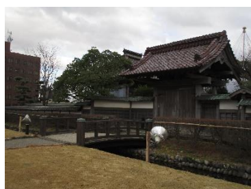
ライトアップ照明設置の様子 H30.12
