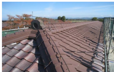
4番蚕室三階屋根椋瓦葺き 避雷設備設置(竣工)
