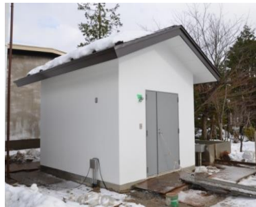
ポンプ室建築工事
