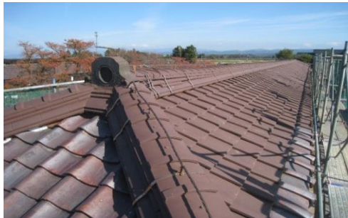
史跡松ヶ岡開墾場 4番蚕室三階屋根根椋瓦葺き 避雷設備設置(竣工)
