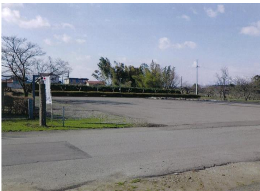
駐車場部(着工前)
