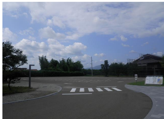
駐車場部(完成)
