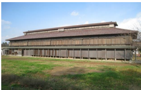
4番蚕室背面(竣工)
