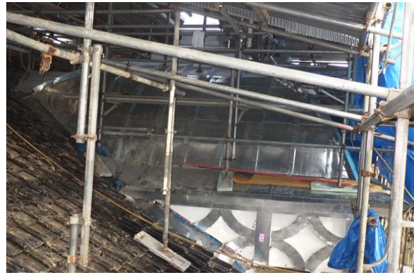
屋根ドーム 作業中
