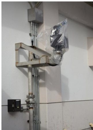
放水銃の設置(旧渋谷家住宅消火)
