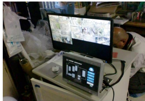
監視設備工事(監視機器の設置)
