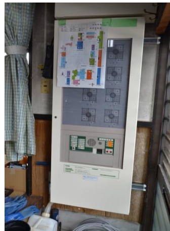
自動火災報知機総合盤の設置(管理棟)
