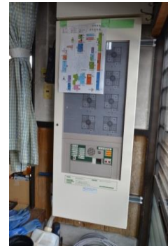
自動火災報知設備の更新
