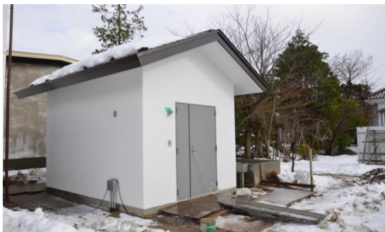
ポンプ室建築工事
