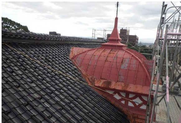
屋根ドーム 作業前
