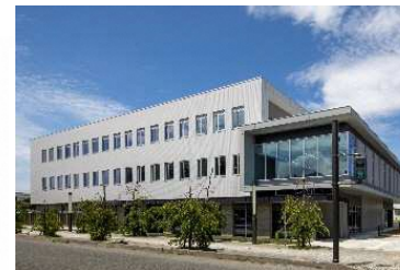
①鶴岡第2地方合同庁舎 R4.7完成
