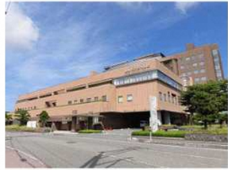
②鶴岡市立荘内病院 H15.7完成
