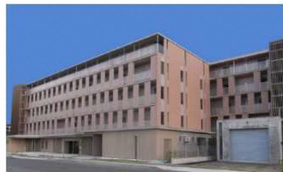
⑪鶴岡市立荘内病院医師公舎 H27.6完成
