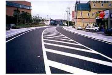
⑥都市計画道路鳥居町新斎部線 H15.7完成
