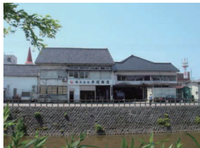
鶴岡水産物地方卸売魚市場(かつての若木座敷地)
