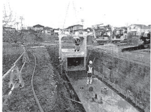
雨水幹線工事状況
