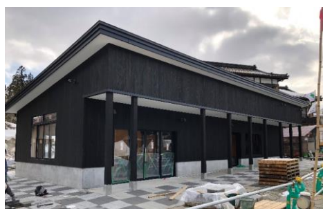
3/3現在の工事状況
