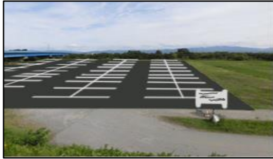
▲駐車場区画線整備(イメージ写真)
