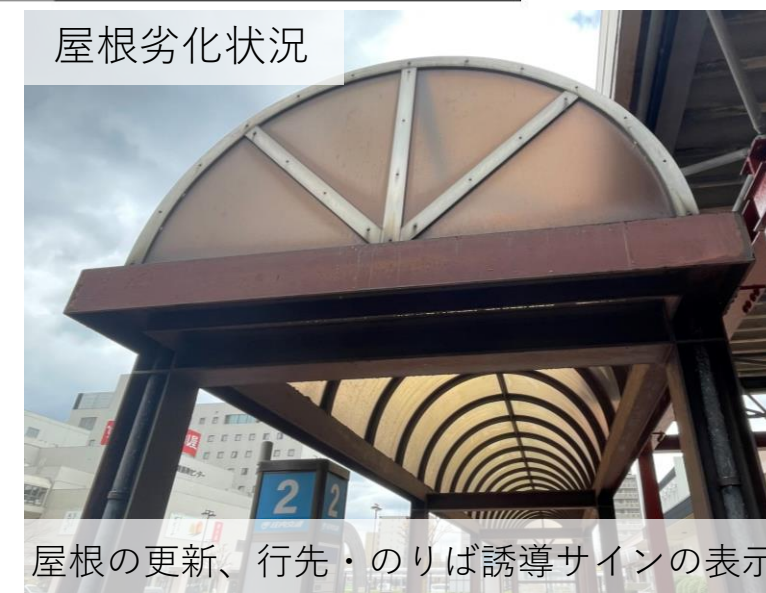
鉄骨のケレン・錆止め・明るい色彩へ塗装
