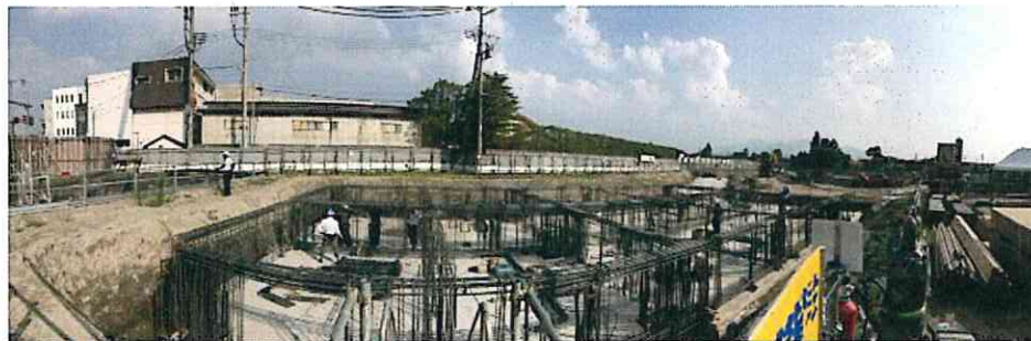
練習室付近(敷地北側)の基礎の鉄筋工事の様子
