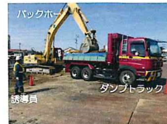
写真：バックホーとダンプトラック
