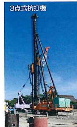
写真：3点式杭打機
