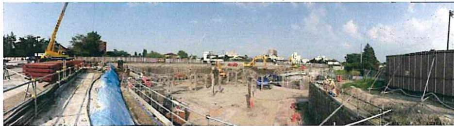
搬入口付近(敷地西側)の掘削工事の様子
