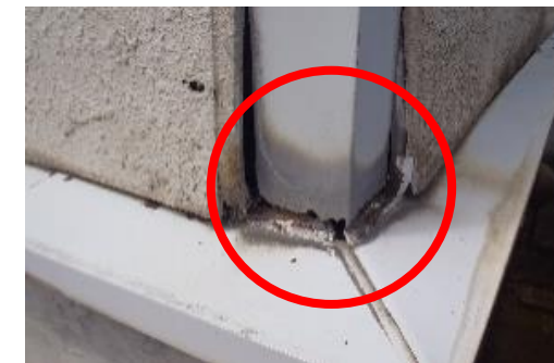
【鶴岡センター】 外壁鉄骨の断裂
