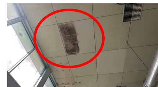
【櫛引センター】 下処理室天井の水漏れ跡
