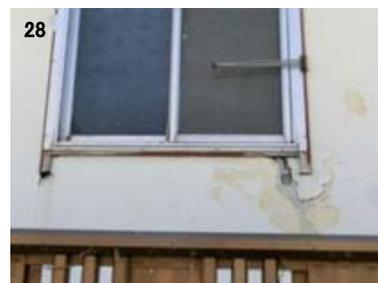
28 外壁にひび割れと剥離
