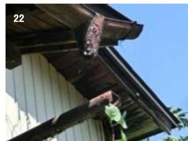
雨どいの破損・軒天材の腐食
