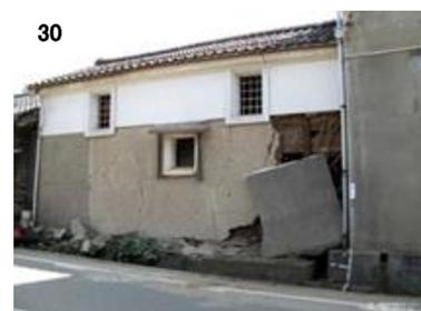
30 大規模なひび割れ及び剥落
