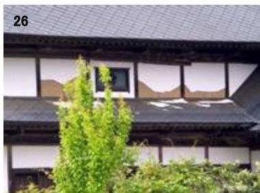
26 外壁仕上げの一部が剥落
