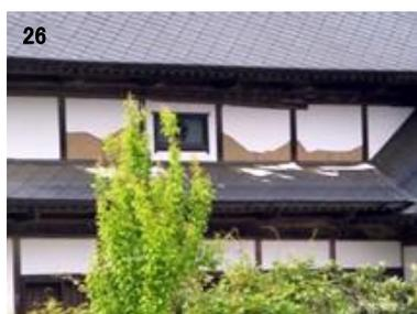
外壁仕上げの一部が剥落
