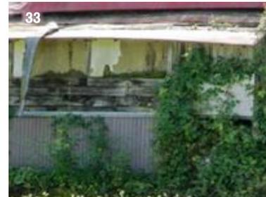
33 著しい劣化による壁剥落
