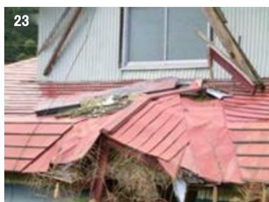
23 著しい変形と樋などの破損
