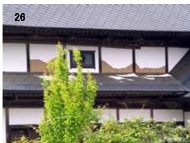
26 外壁仕上げの一部が剥落
