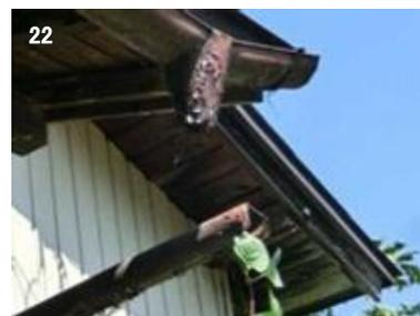
22 雨どいの破損・軒天材の腐食
