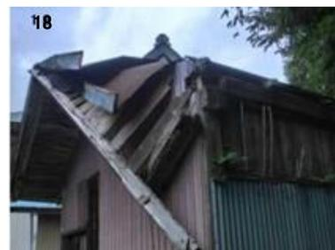
構造部材の大規模な損傷
