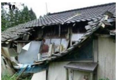
構造部材の大規模な損傷
