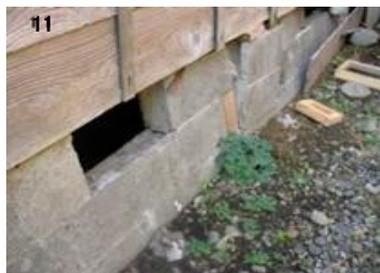
基礎に著しい損傷と傾斜
