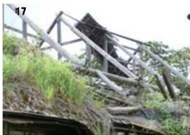
構造部材の大規模な損傷
