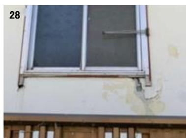
28 外壁にひび割れと剥離
