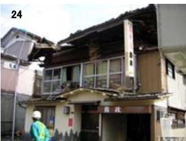
24 屋根が著しく破損している
