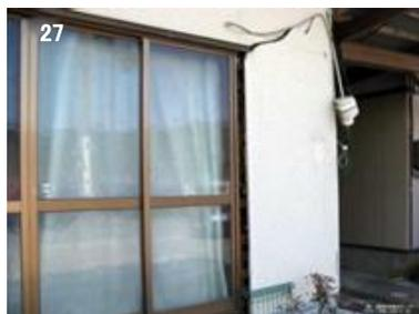
27 外壁にひび割れと剥離
