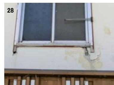
外壁にひび割れと剥離
