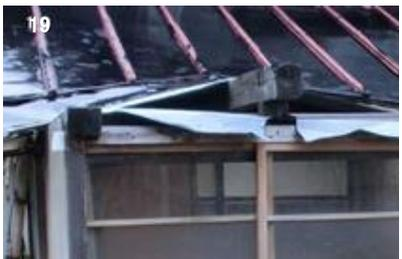
構造部材の大規模な損傷
