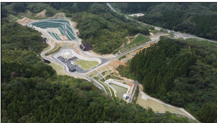
鶴岡市一般廃棄物最終処分場
