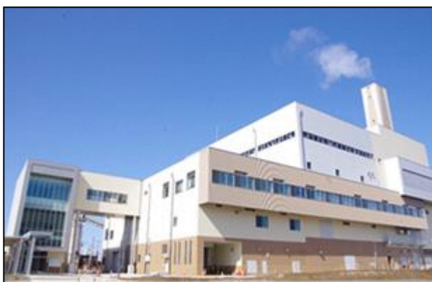
ごみ焼却施設
