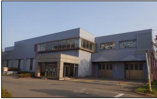
鶴岡市し尿処理施設
