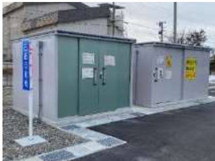
ごみ焼却施設内の古紙回収棟
