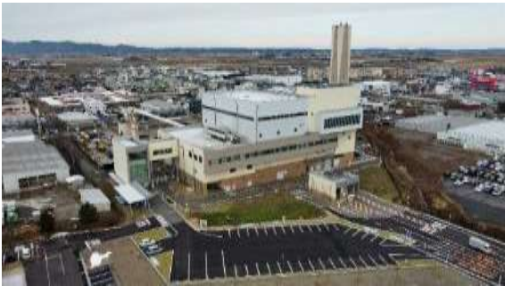
ごみ焼却施設の外構整備が完了
