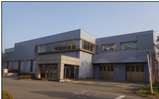
鶴岡市し尿処理施設
