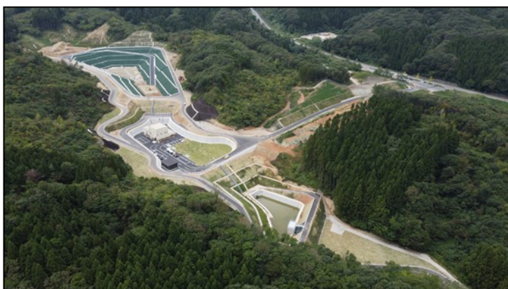
鶴岡市一般廃棄物最終処分場
