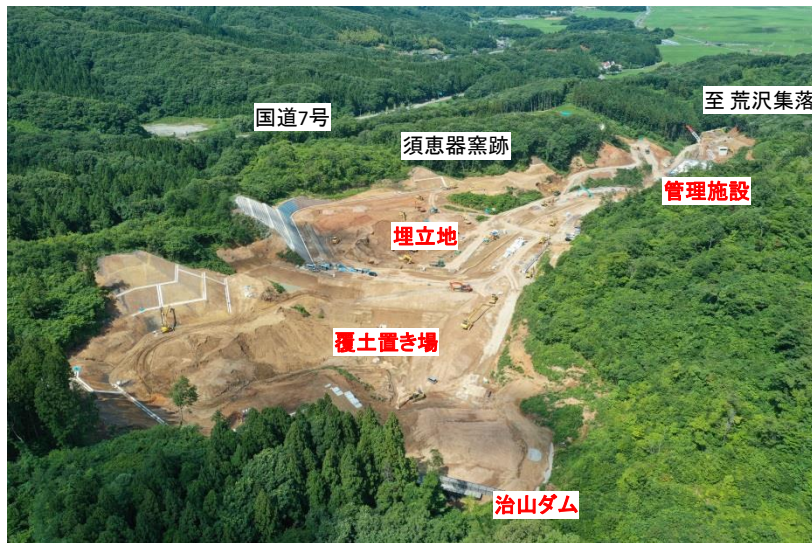
■処分場整備箇所全景 (令和2年7月30日 ドローンにて撮影)
