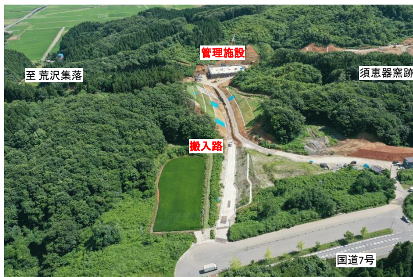
■管理用道路工(工事用道路)整備状況
