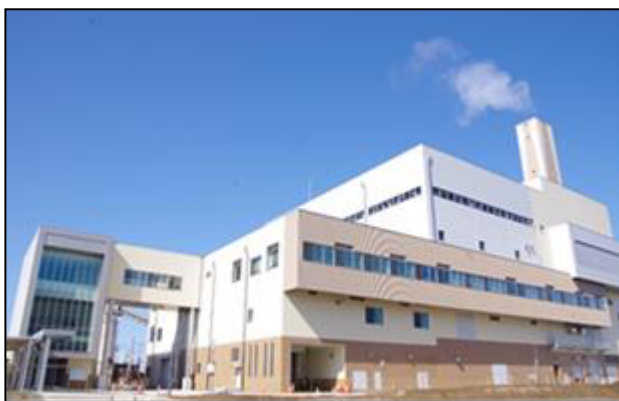
ごみ焼却施設
