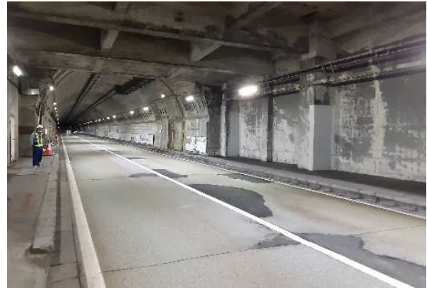
整備後(照明灯のLED化)
