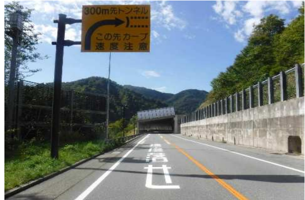
施工後(「速度落せ」の路面標示)
