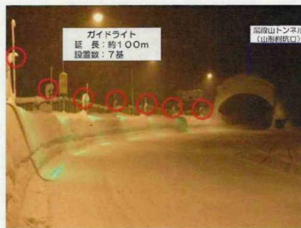
▲カーブ箇所での視線誘導による事故防止
