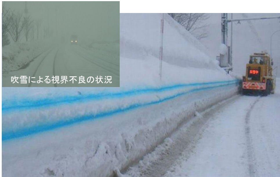
▲【継続】視界不良時の対策として雪堤へ視線誘導線を噴霧
