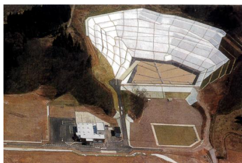
竣工時（1997年（平成9）4月）
