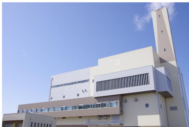
鶴岡市ごみ焼却施設
