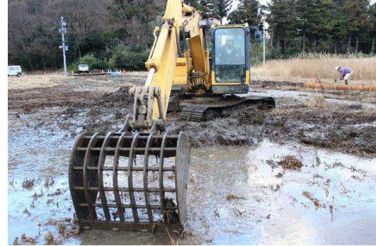
根茎除去できるようにアームの先にはスケルトンバケットを取り付けた
