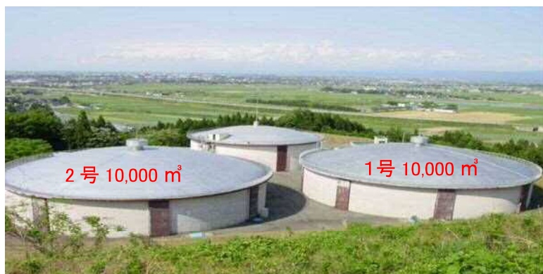
高坂配水池 PC タンク(1号池・2号池、令和2年度～3年度耐震化工事完成)
