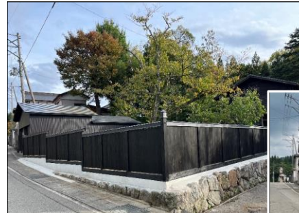
修景整備実施後
