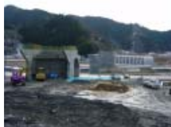
仮称温海インターチェンジ付近
