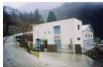
温海町浄配水場
