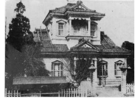
当時の鶴岡警察署庁舎 1884(明治17)年建築 (鶴岡市郷土資料館提供)
