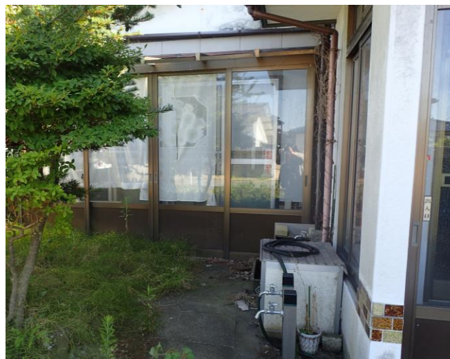
玄関脇南東側を北東側から撮影
