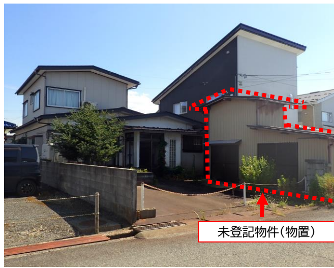
北側前面道路の北東方から撮影
