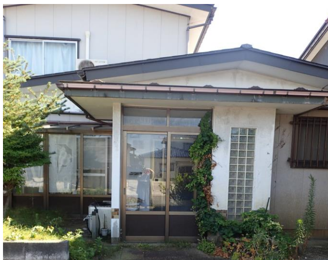
玄関風除室前
