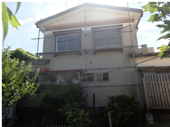
北西方敷地内から居宅を撮影
