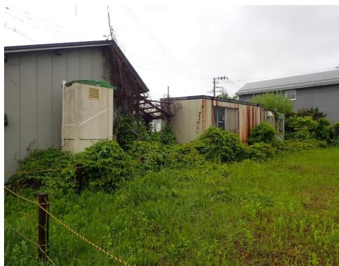
西側前面道路の南西方から撮影
