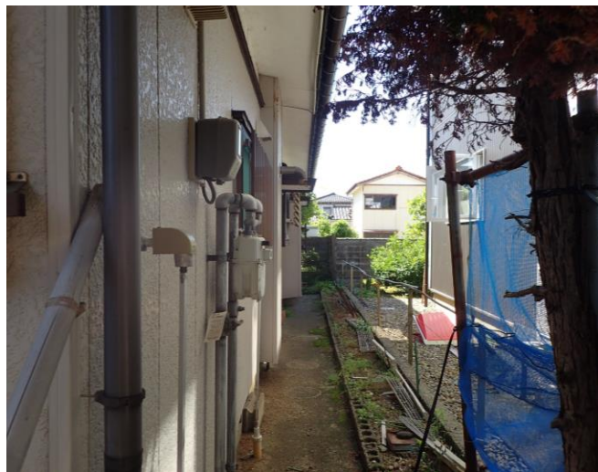
家屋西側側面を北側から撮影
