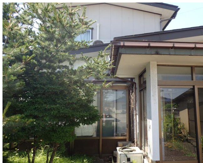
玄関脇南東側を北東側から撮影
