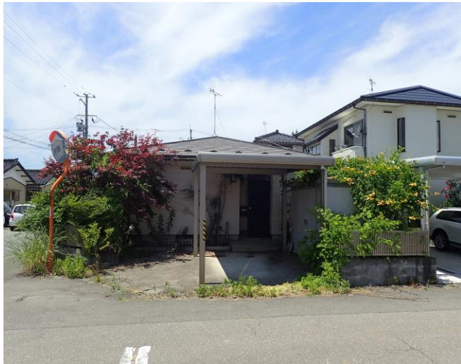
北東側前面道路の北東方から撮影
