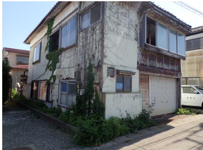
南西側前面道路の南西方から居宅兼工場を撮影
